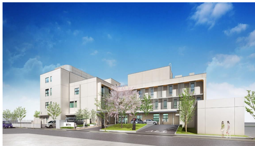
山側外観（住宅地より望む）
